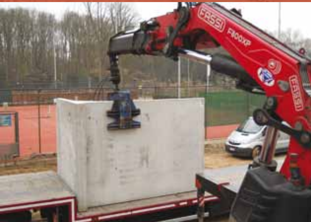
De drie meter hoge keerwanden zijn met een trailer aangevoerd.
